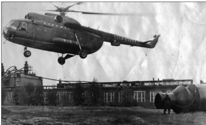
*Монтаж «Циклона» с помощью вертолётa.*
